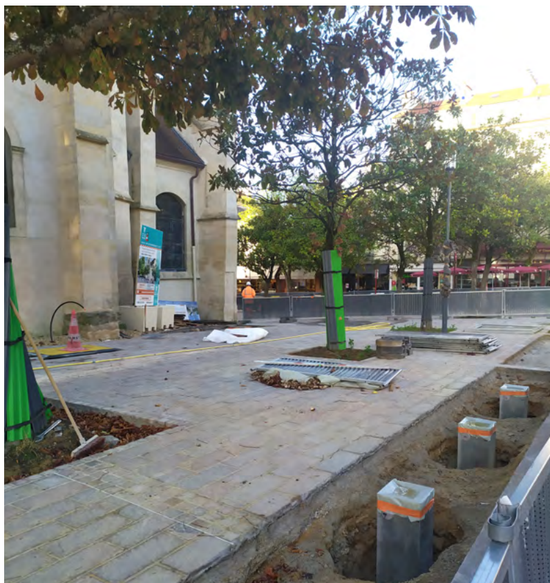
Rénovation de la place Frédéric-Mistral, parvis de l'église
