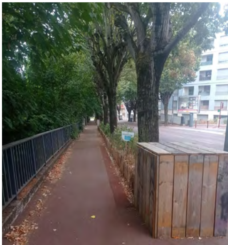
Deux réservoirs ont été installés cet été avenue Raymond-Poincaré pour y stocker l'eau de pluie récupérée sur le site sportif et de loisirs des Blagis, et humidifier ainsi les bandes végétalisées de l'avenue
