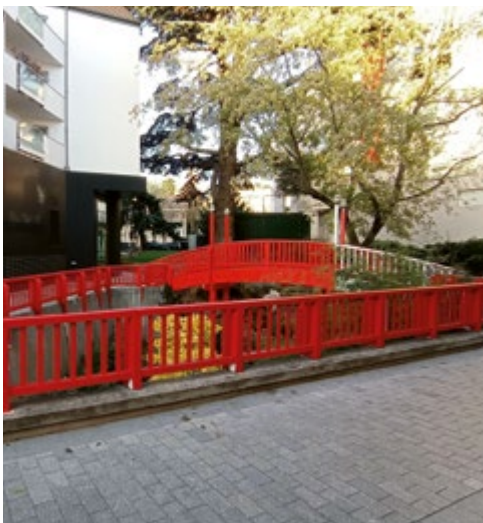
Mise en peinture du pont japonais situé place Leamington-Spa
