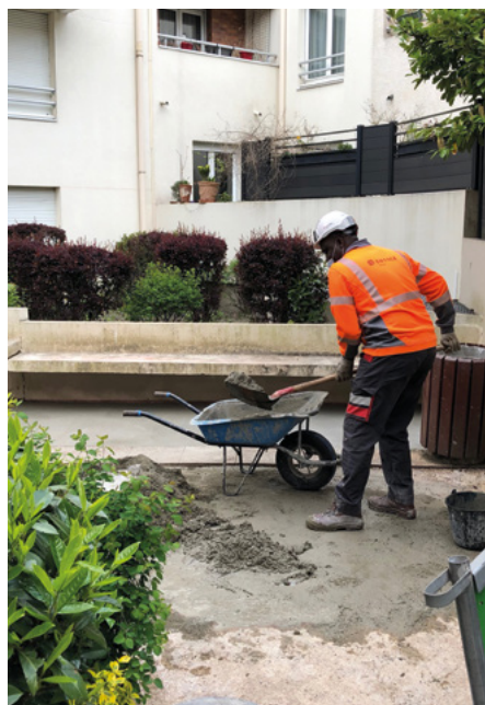
Reprise des revêtements de l'îlot Benoît
