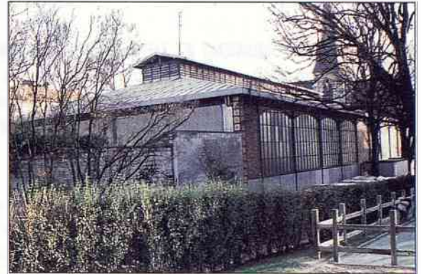
Cette rénovation prend une dimension esthétique et historique forte puisqu'il s'agit de rendre à ce bâtiment le caractère qu'il avait au début du siècle, tout en améliorant sa fonctionnalité.
