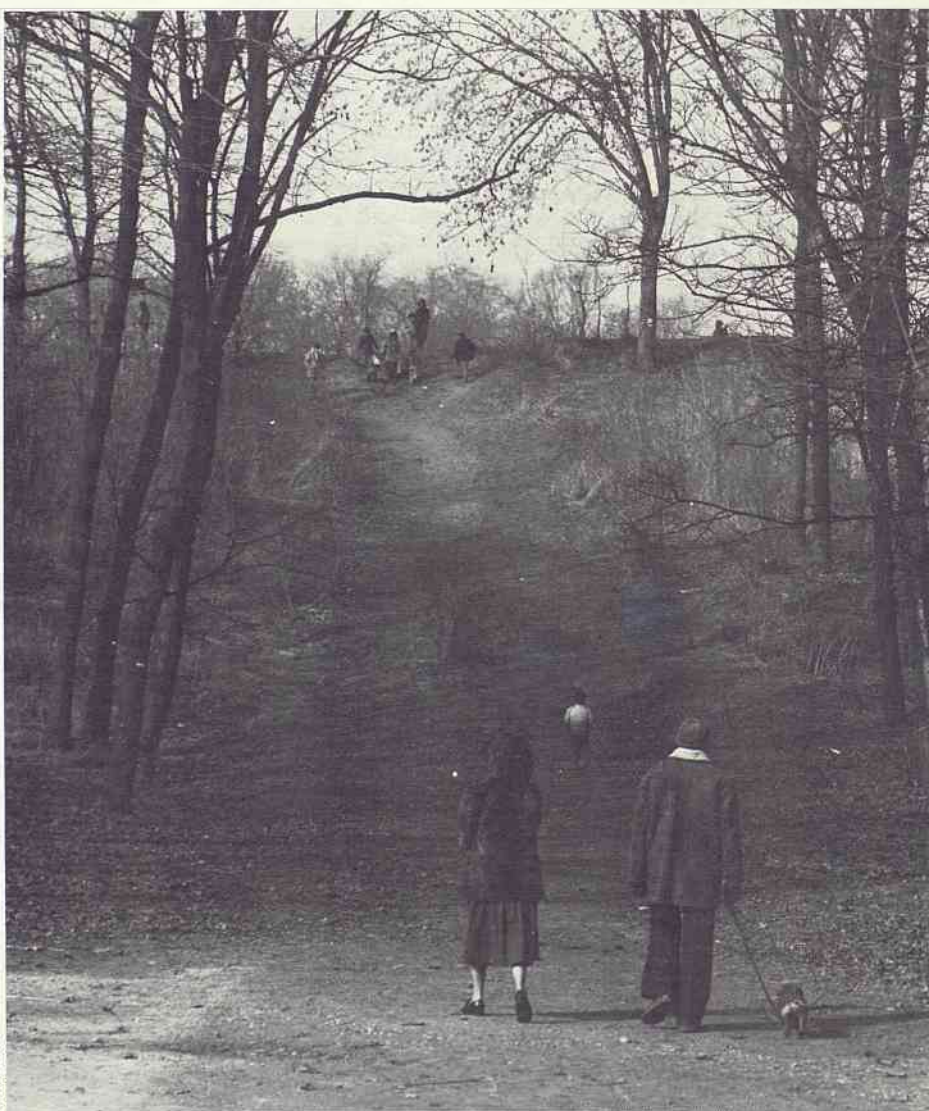
Parmi les rares travaux jugés urgents par le Conseil général : la construction d'escaliers permettant à tous d'accéder au Grand Canal, à la Terrasse des Pintades et à la Plaine des Quatre-Statues.
