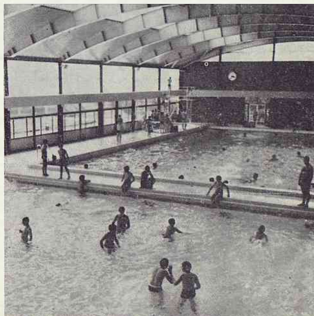
A certaines heures, la Piscine est réservée aux scolaires.
