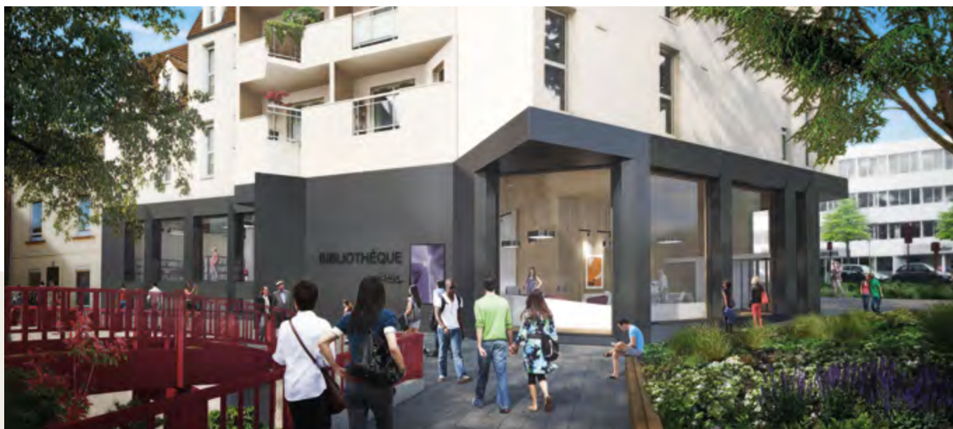
Les travaux de modernisation de la bibliothèque, actuellement en cours, se termineront en 2019.
