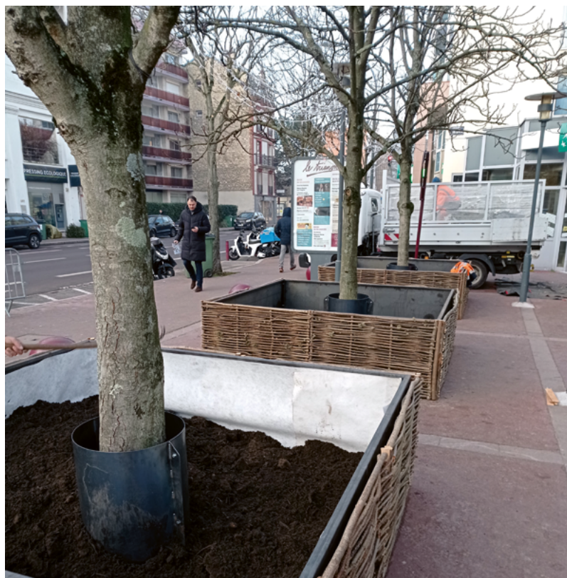
Installation des bacs d'arbres square Robinson.
