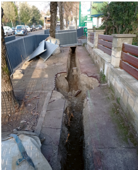
Travaux d'enfouissement des réseaux aériens.
