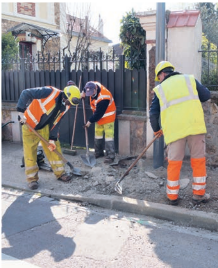
En mars, le Sipperec et Enedis reprenaient les trottoirs de la rue des Chéneaux après l'enfouissement des réseaux.
