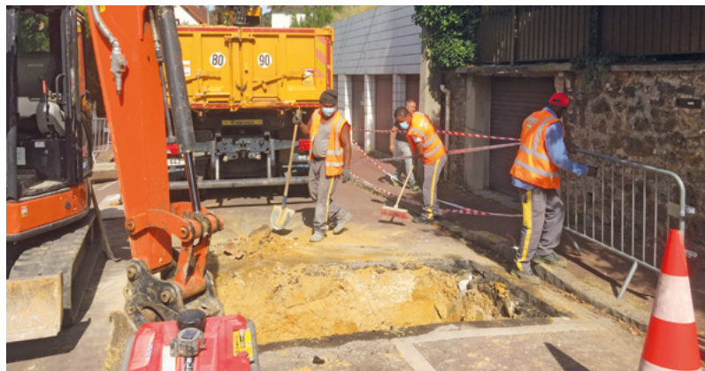
Mi-juin, intervention d'ouverture de chaussée rue Pasteur à la suite de l'observation d'un fontis (effondrement du sol en surface) dû à une fuite sur le réseau.
