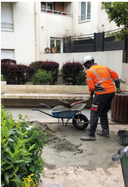
Reprise des revêtements de l'îlot Benoît
