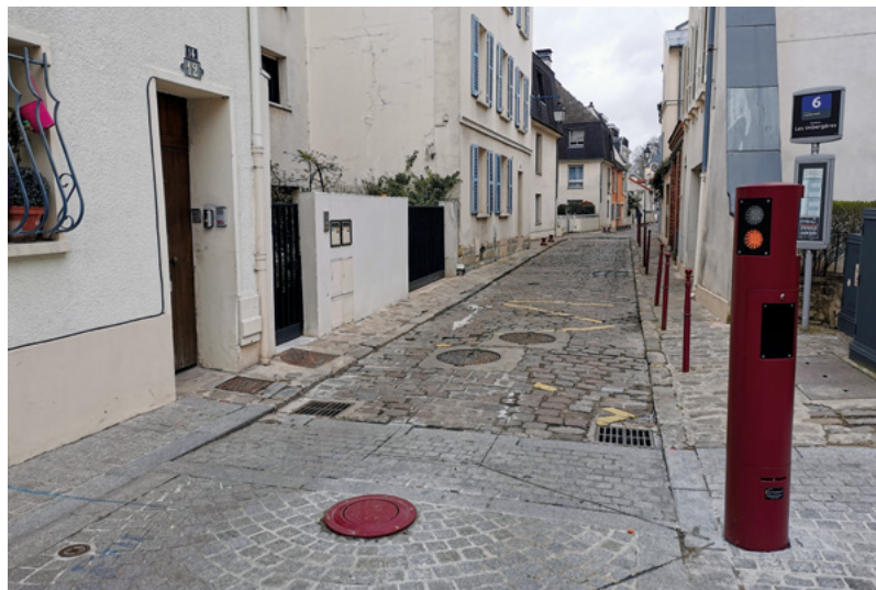
Mise en place d'une borne d'expérimentation de la piétonnisation rue des Imbergères (entre les rues Florian et du Docteur-Berger). Cette partie de la rue des Imbergères sera interdite à la circulation à certaines heures à compter du 12 avril 2021
