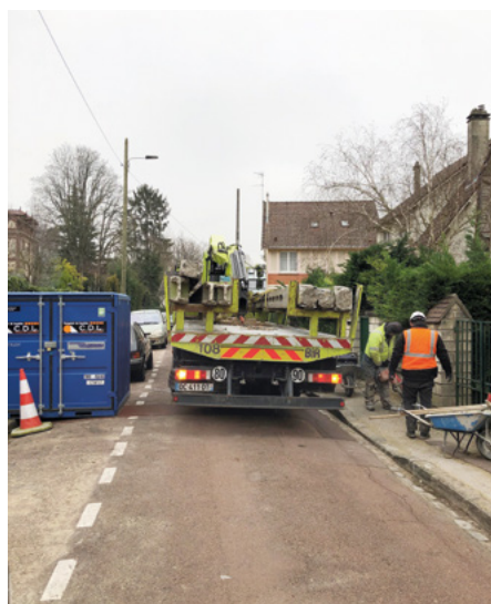
Retrait des poteaux et installation d'un éclairage provisoire à l'occasion de l'enfouissement des réseaux et de la rénovation de l'éclairage public rue Madeleine-Crenon
