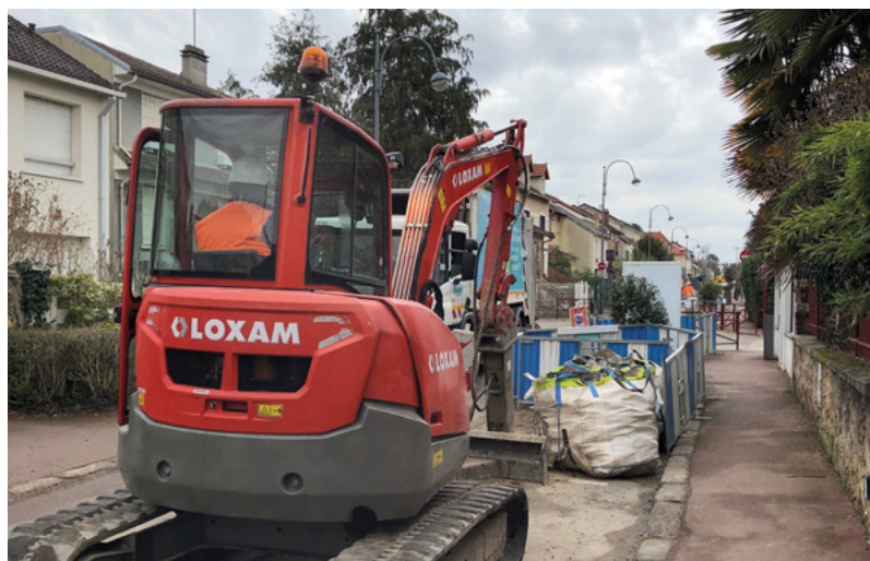
Reprise des canalisations d'eau potable rue de la Marne
