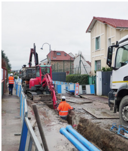
Reprise des canalisations d'eau potable rue de la Marne.
