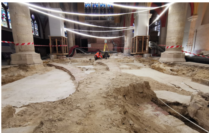
La campagne de fouilles archéologiques de l'Institut national de recherches archéologiques préventives (Inrap) se poursuit jusqu'au 19 février 2021 dans la nef de l'église Saint Jean-Baptiste.
