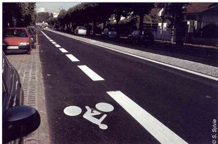
Terre-plein central en pavé, voie cyclable redessinée, chaussée refaite... L'avenue Georges-Clemenceau - voie départementale - a fait peau neuve. Le revêtement innovant - drainant et anti-bruit - devrait profiter à tous.
