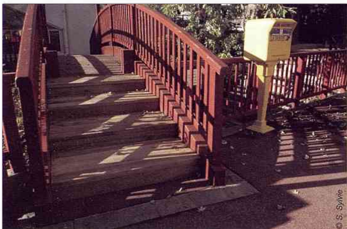
Par temps de pluie, le franchissement du pont japonais situé place Leamington Spa pouvait s'avérer périlleux... L'installation de marches en bois respectant l'aspect du revêtement existant a pallié cette difficulté.
