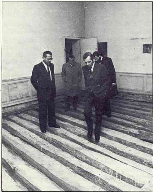
Au premier étage du Petit Château, M. le Préfet, impressionné par l'importance des travaux à réaliser
