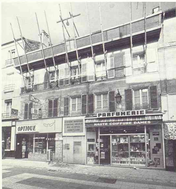
Au 86, rue Houdan, une remise en état complète
