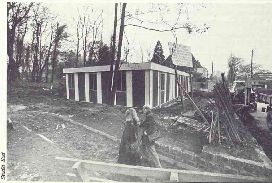
Mlle Fihey, Directrice du Centre P.M.I. et Mme Nimer, responsable de la halte-garderie visitent le chantier de la nouvelle halte-garderie dont l'ouverture devrait intervenir vers le 15 janvier
