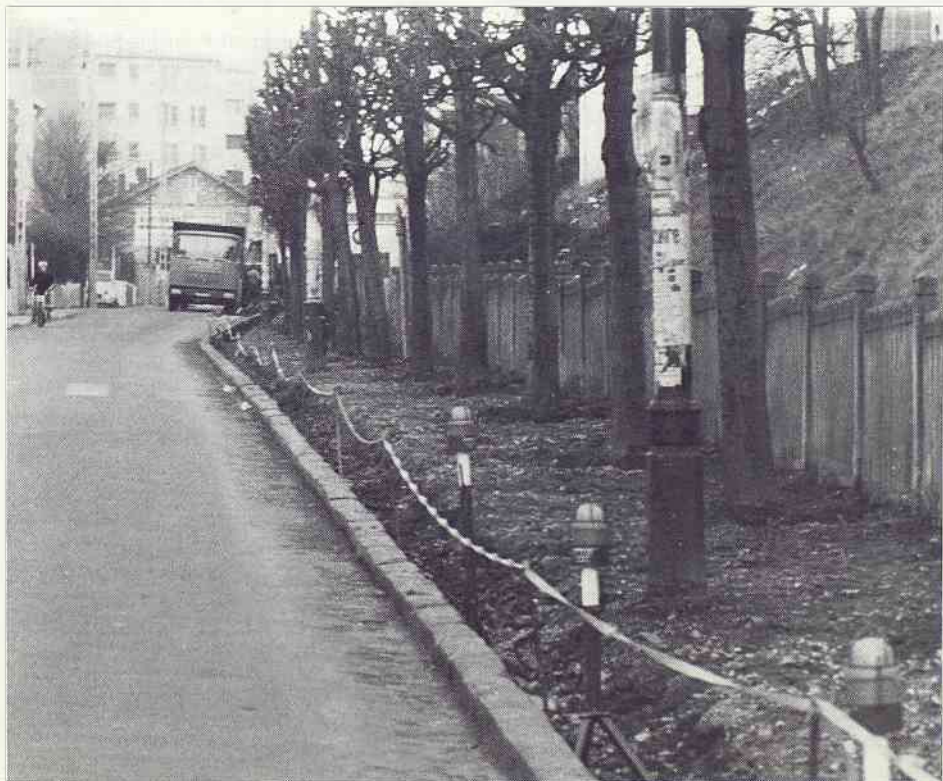
Les travaux de l'avenue de la Gare
