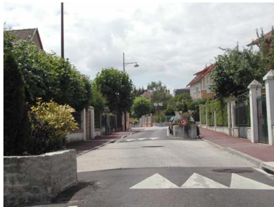
Des jardinières en pavés délimitent les emplacements de stationnement en chicanes et des zones de croisement, qui permettent aux véhicules de se croiser dans ces voies maintenues à double sens.
