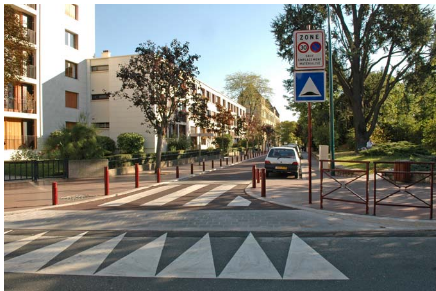
L'entrée de la zone 30 rue Gaston Levy est matérialisée par un plateau surélevé.
