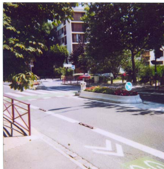
Bande cyclable sur voie départementale : rue Houdan
