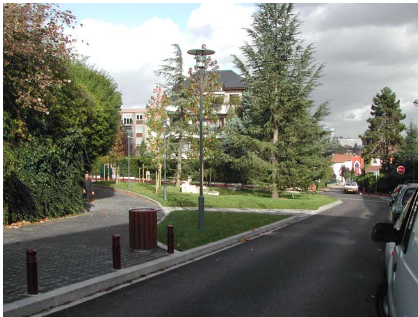
L'aménagement d'une liaison piétonne et cycliste rue Lakanal : la chaussée a été rétrécie de façon à réserver un espace élargi aux modes doux de circulation
