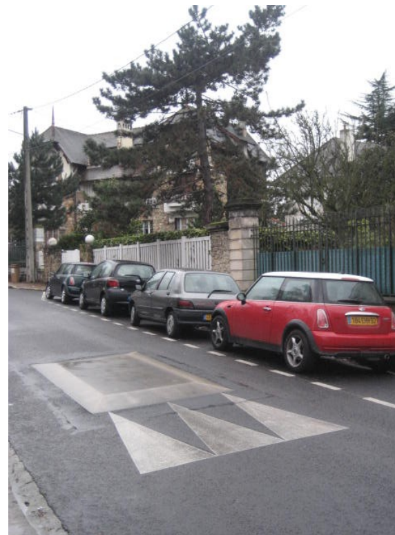
La mise en place de coussins berlinois permet de réduire la vitesse sans nécessiter de remaniements importants de la chaussée : ici la rue Charles Peguy (2006)
