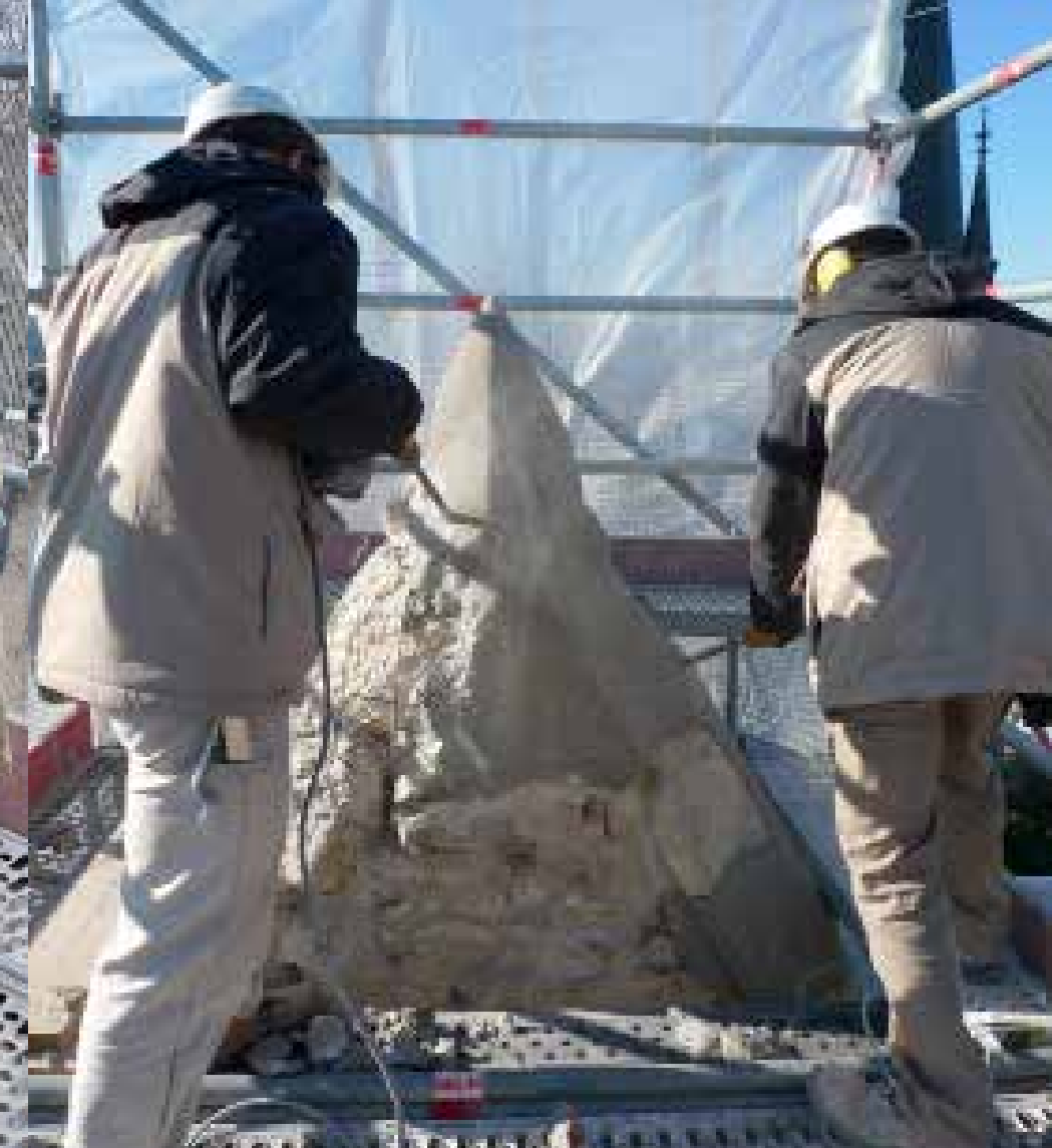
Février 2016 - Travail préparatoire de repérage des pierres à changer
